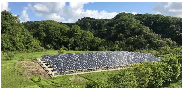
「小矢部八伏市民発電所」が完成(2021.3.30)
